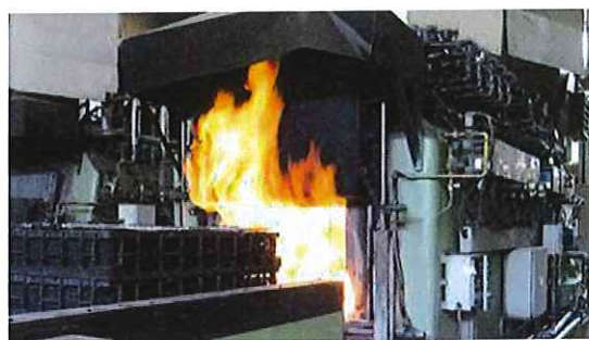
Horno de tratamiento térmico
